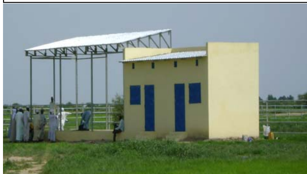
postes de sortie de bétail à Ngéli
